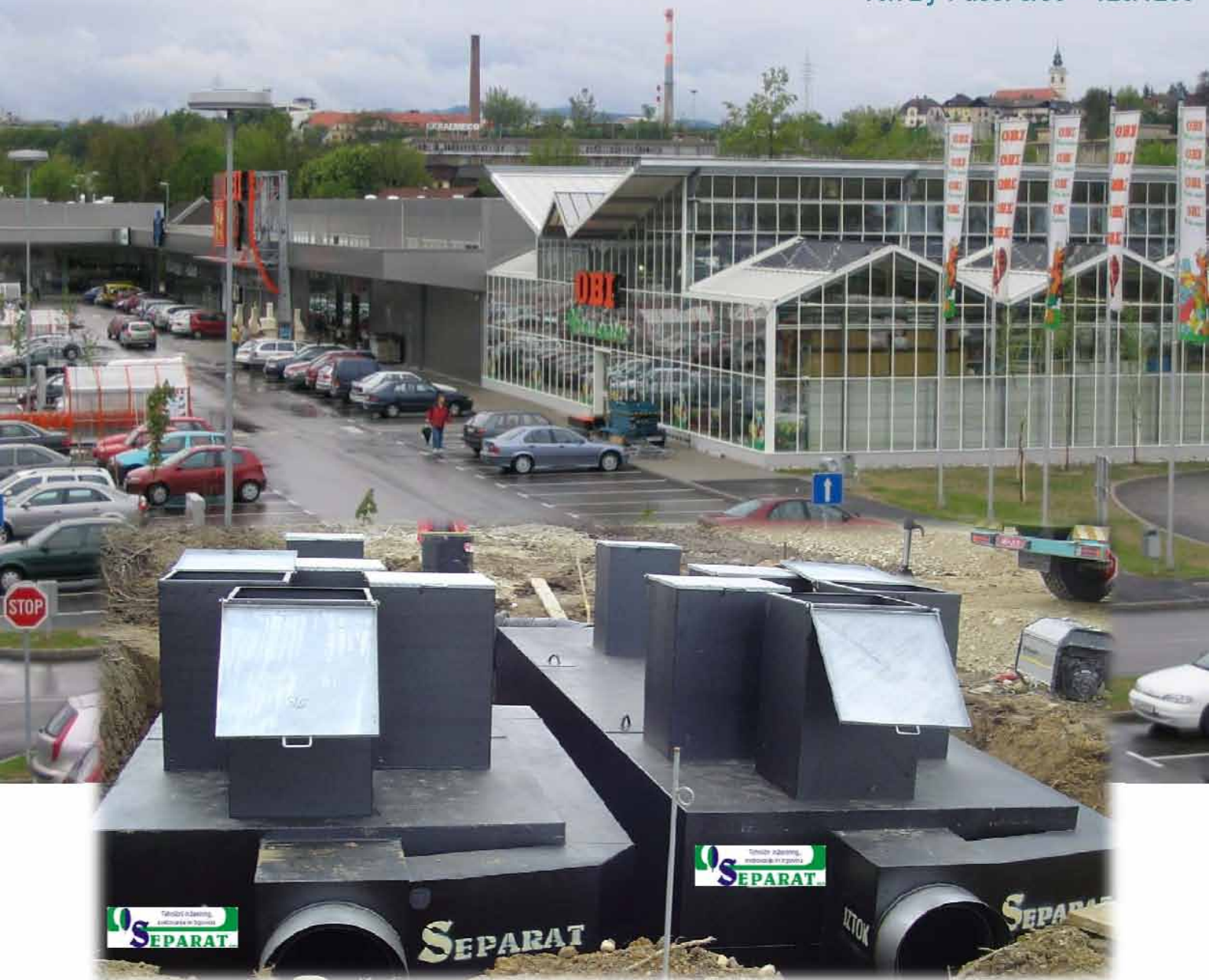
Izločevalniki lahkih tekočin z By-passom (5x, 10x)
